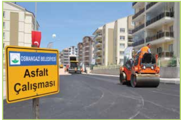
ASFALT KAPLAMA ÇALIŞMASI
