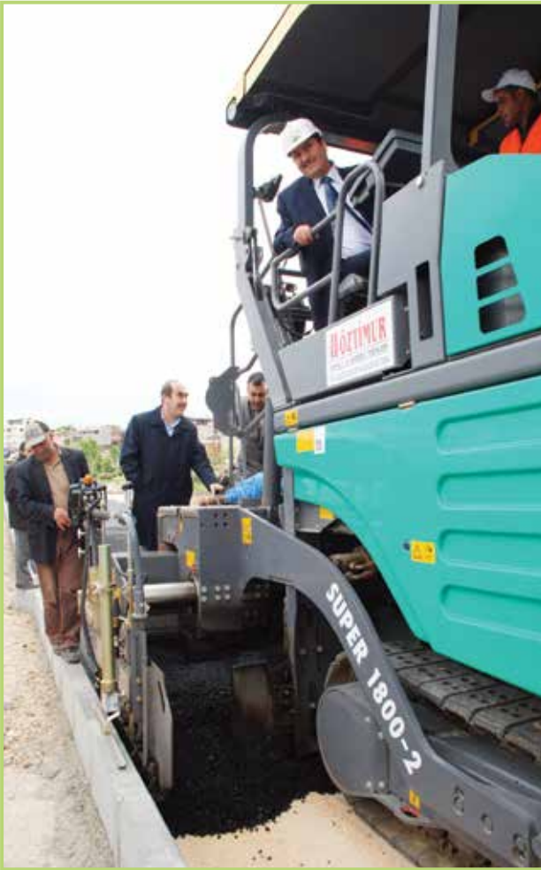
YAMA ASFALT ÇALIŞMASI
