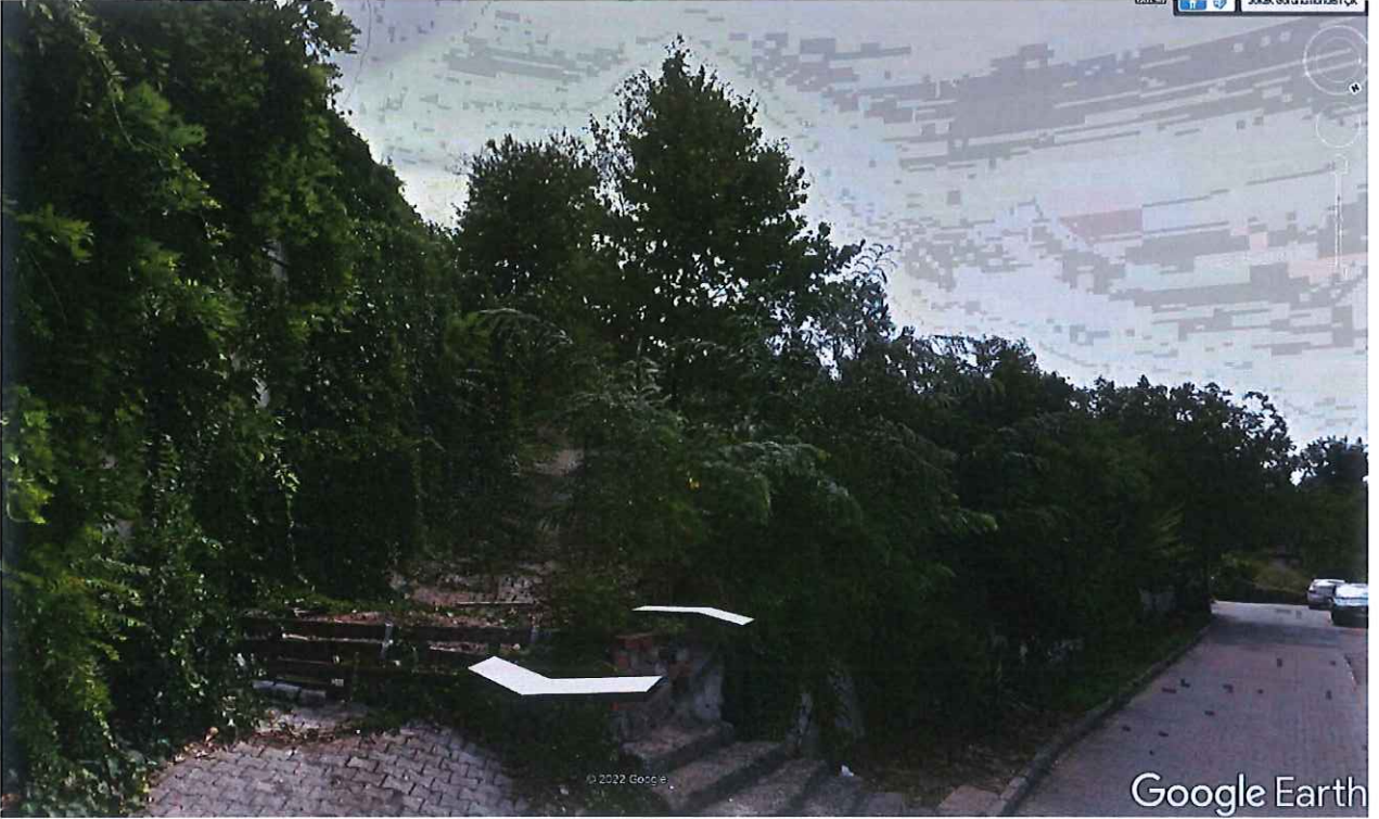
4151 ada 20 parselin kuzey cephesinden görünümü
